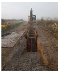
Pose du réseau assainissement Chemin de Chalencou
