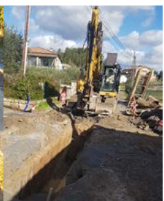
Pose des canalisations d'eau potable et assainissement par l'entreprise Faurie chemin du Brujas
