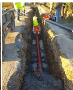
Pose des canalisations d'eau potable et assainissement par l'entreprise Faurie chemin du Brujas
